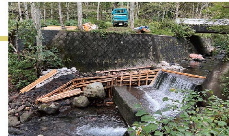
手作り魚道の補修作業
